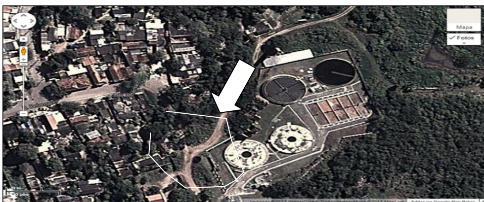
Imagem 03: Estação de Tratamento de Esgoto. Fonte Google Maps
